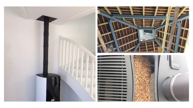
Les maisons sont en structure bois : planchers intermédiaires en bois et murs à ossature bois. Les simulations thermiques dynamiques ont permis de mettre en évidence le sujet sensible du confort estival, et conduit à l'ajout d'une chape béton sur le plancher intermédiaire pour apporter une inertie supplémentaire.
