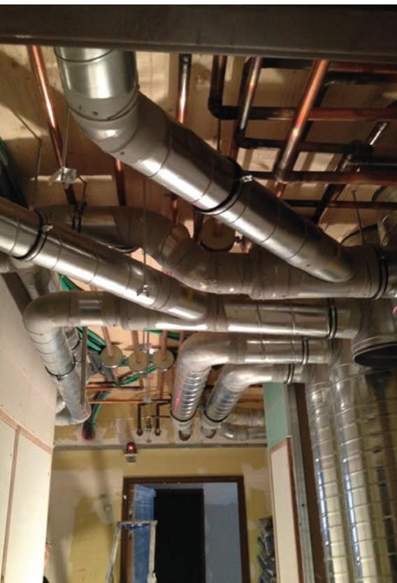
Le chantier de Montreuil a nécessité de bien appréhender l'encombrement des réseaux aérauliques et des fluides en raison de la ventilation double flux et de la présence de batteries. Les faux-plafonds dans l'entrée des logements sont très fortement encombrés.
