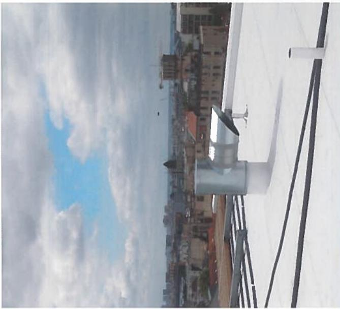
► La toiture terrasse non accessible est couverte d'une membrane réflechissante qui limite l'échauffement du bâtiment et les effets d'îlot de chaleur.
